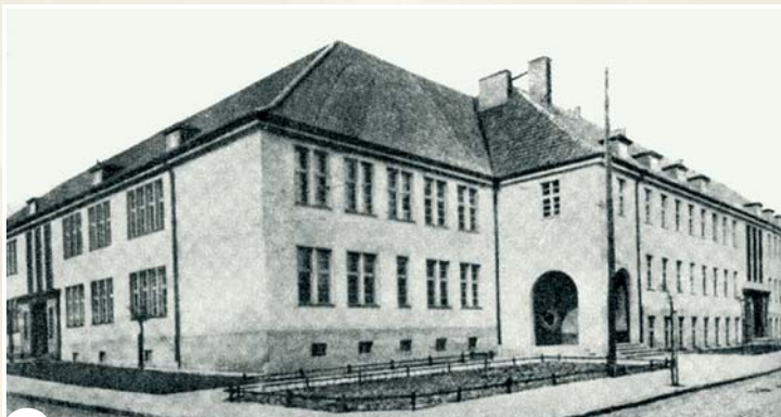
Budynek gimnazjum w Kwidzynie / Das Schulgebäude des Gymnasiums in Kwidzyn
