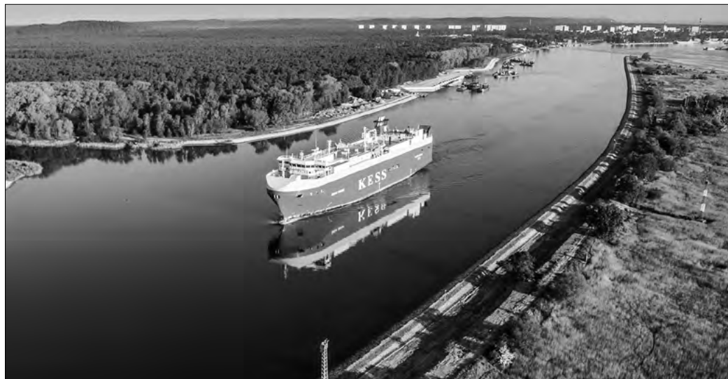
Tor wodny Świnoujście-Szczecin (Źródło www.eswinoujście )
